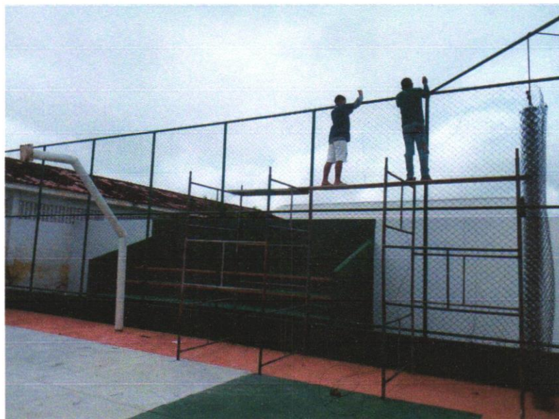
Foto 02 – ALAMBRADO PARA QUADRA POLIESPORTIVA, ESTRUTURADO POR TUBOS DE ACO GALVANIZADO, (MONTANTES COM DIAMETRO 2", TRAVESSAS E ESCORAS COM DIÂMETRO 1 ¼ ), COM TELA DE ARAME GALVANIZADO, FIO 10 BWG E MALHA QUADRADA 5X5CM (EXCETO MURETA). AF_03/2021
